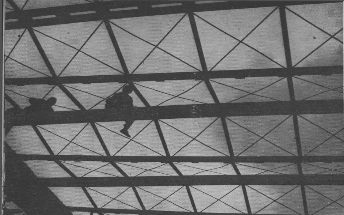
Montaż konstrukcji dachu fabrycznej hali
