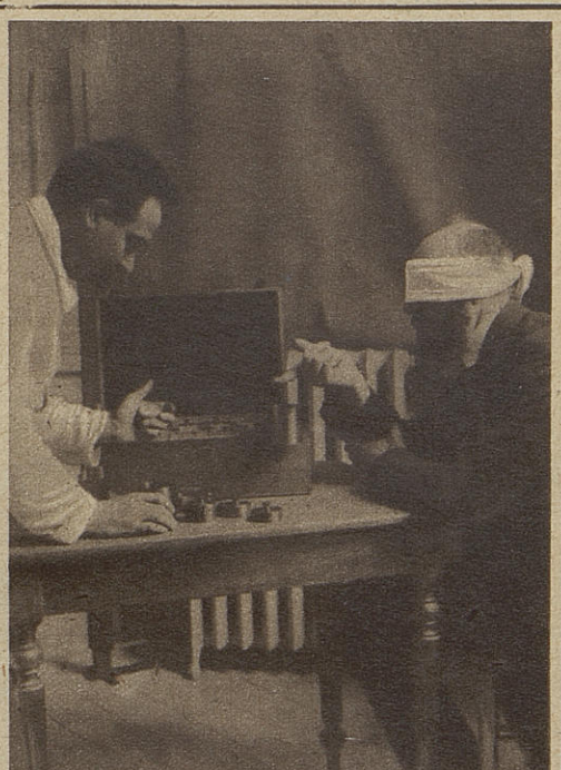
LA MESURE DE LA SENSIBILITÉ MUSCULAIRE PAR LE « MVO-ESTHEROMETRE ». UN SUJET DONT LES YEUX SONT BANDÉS ESTIME LES POIDS DES PETITS CYLINDRES EN MÉTAL.
