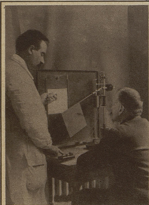
L'APPAREIL, ELECTRO-MAGNETIQUE DE LABY POUR MESURER LA MEMOIRE USUELLE. L'EXPERIMENTATEUR LIT UNE NOTE PLACÉE SUR UNE PLAQUE DECOUVERTE UN INSTANT.
