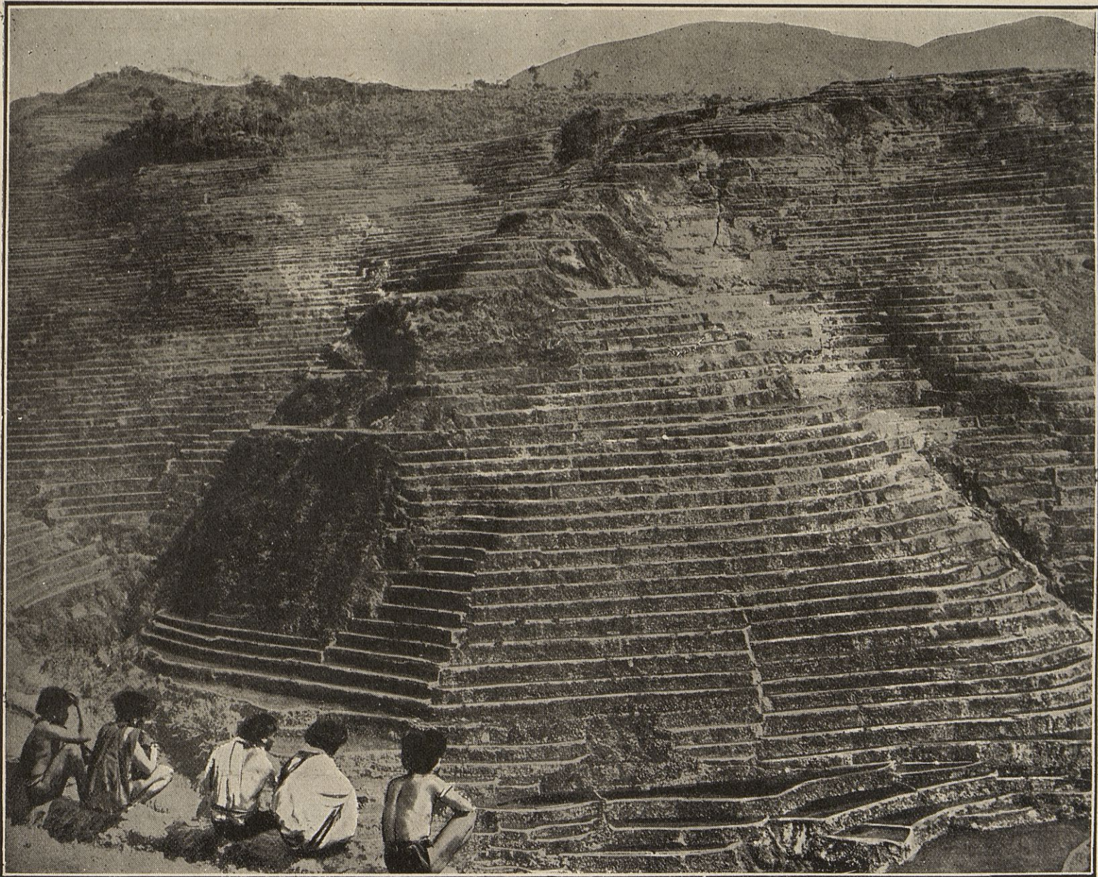
Grâce à l'ingéniosité des Américains, le riz, qui ordinairement est une culture des plaines les plus basses, est cultivé aux Philippines sur les montagnes. Tout un massif a été couvert, comme on le voit ici, de terrasses dont les murs, en maçonnerie grossière, retiennent les eaux pluviales extrêmement abondantes pendant la saison des pluies. Le sol conserve ainsi l'humidité voulue pour la culture. Ce travail considérable, qui a demandé plusieurs années, a été exécuté par des natifs.
