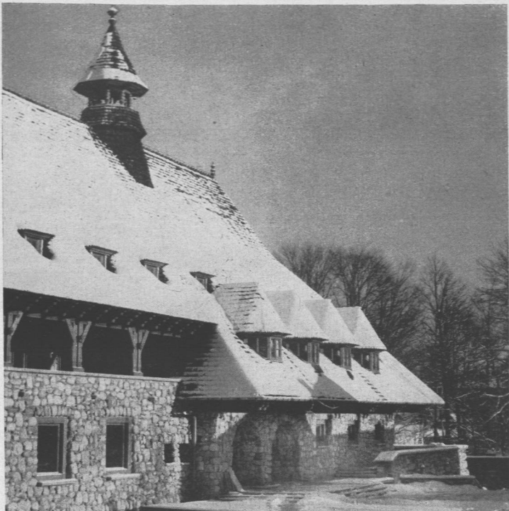
W Zakopanem został otwarty nowy wielki hotel-schronisko o 622 miejscach. Wszelkie wygody zapewnione, łącznie z suszarnią garderoby, warsztatem narciarskim, przechowalnią sprzętu.
