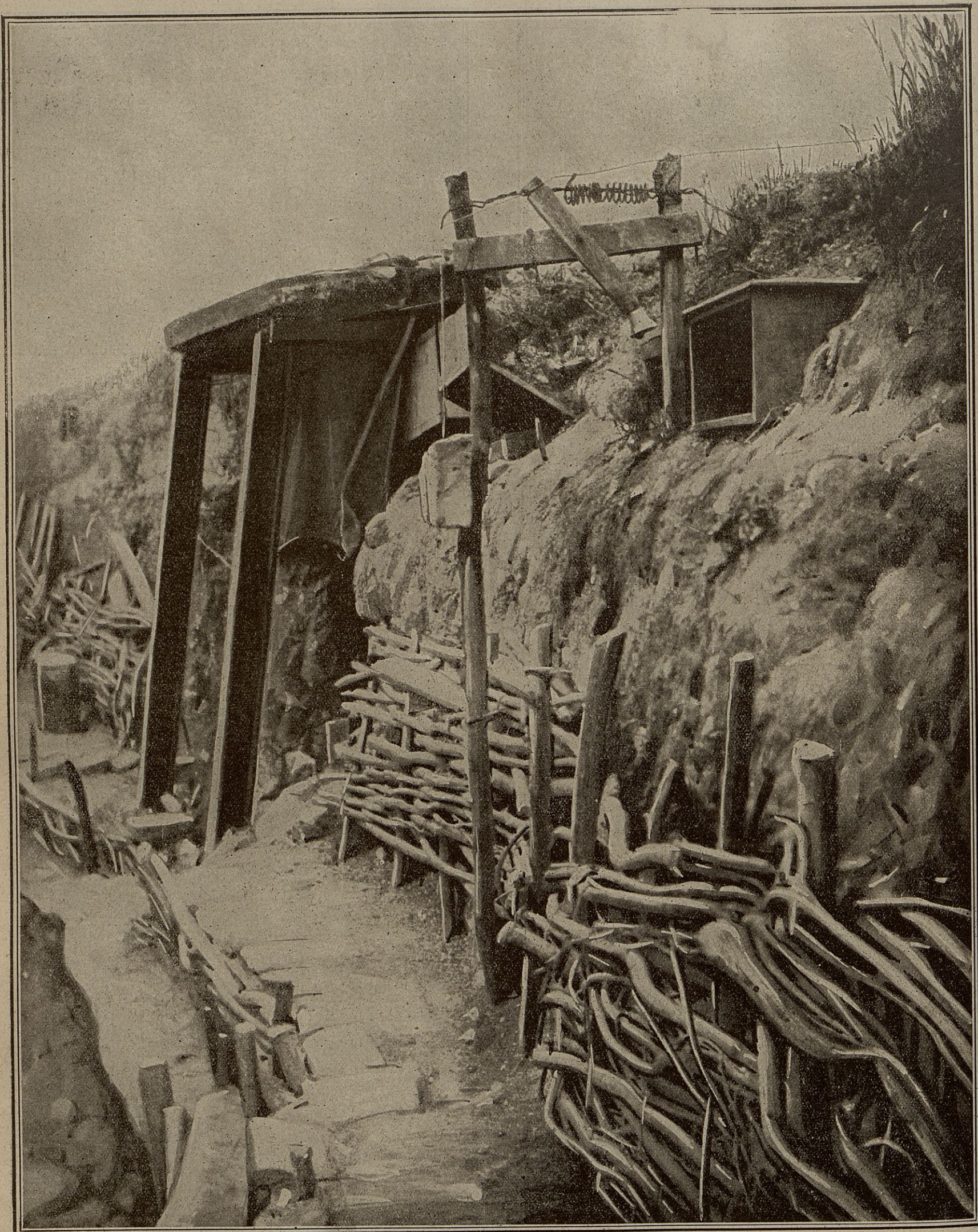
Cette photographie d'une tranchée de première ligne en Picardie donne une idée exacte des précautions que l'on prend pour éviter une surprise des Allemands ; au premier plan, le long d'un piquet, est suspendue une sonnette qu'un fil de fer relie au poste d'écoute ; derrière se trouve la guérite du guetteur ; tout le long du parapet des créneaux pour le tir et aussi la surveillance des mouvements de l'ennemi. A la moindre alerte, la tranchée se garnit de ses défenseurs.
