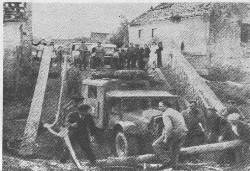
Kłopoty przy budowie przeprawy pod Abbeville. Żołnierze I Dywizji Pancernej gen. Maczka szybko się uporali z przeprawą
