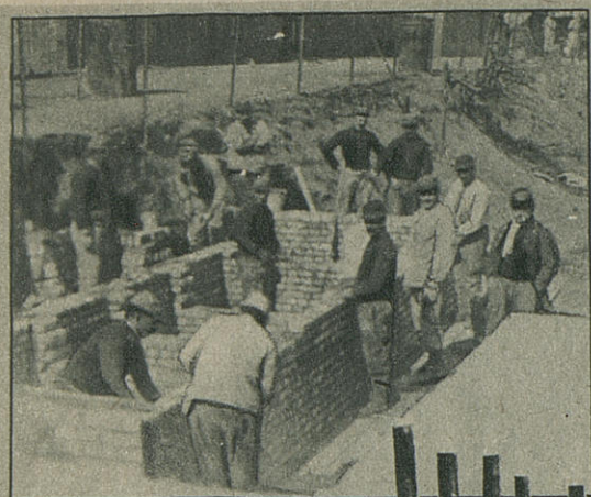
La construction d'un four.
