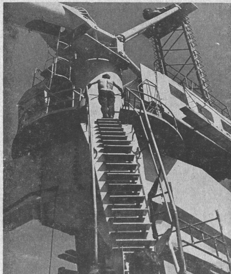
Fabryka maszyn Budowlanych ze Szczecina dostarczyła budowniczym gigantyczny dźwиг podnoszący 15-tonowe elementy na budowie 24-piętrowego gmachu na rogu Marszałkowskiej i Chmielnej
