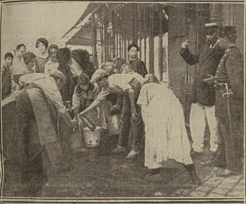
UNE PRISE D'EAU GARDÉE PAR LA POLICE, A PANTIN
