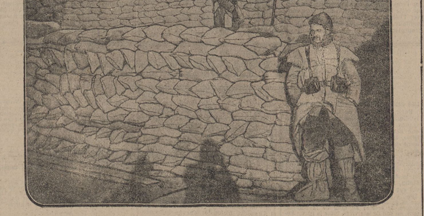
Le terrain étant trop mouvant ou trop humide, il est impossible de creuser des tranchées. Il faut donc construire de véritables fortifications avec des sacs de terre.
