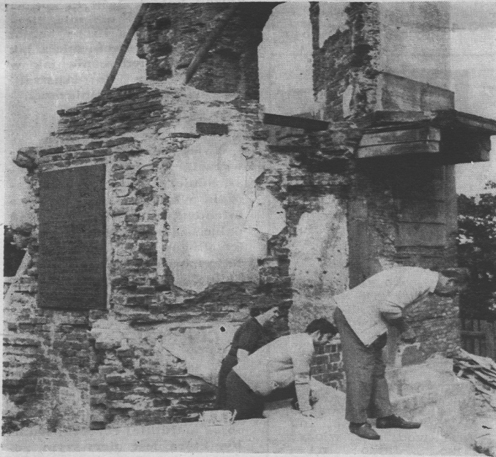
Państwo Pankaninowie przyglądają się pracom konserwacyjnym przy fundamentach Zamku Królewskiego w Warszawie
