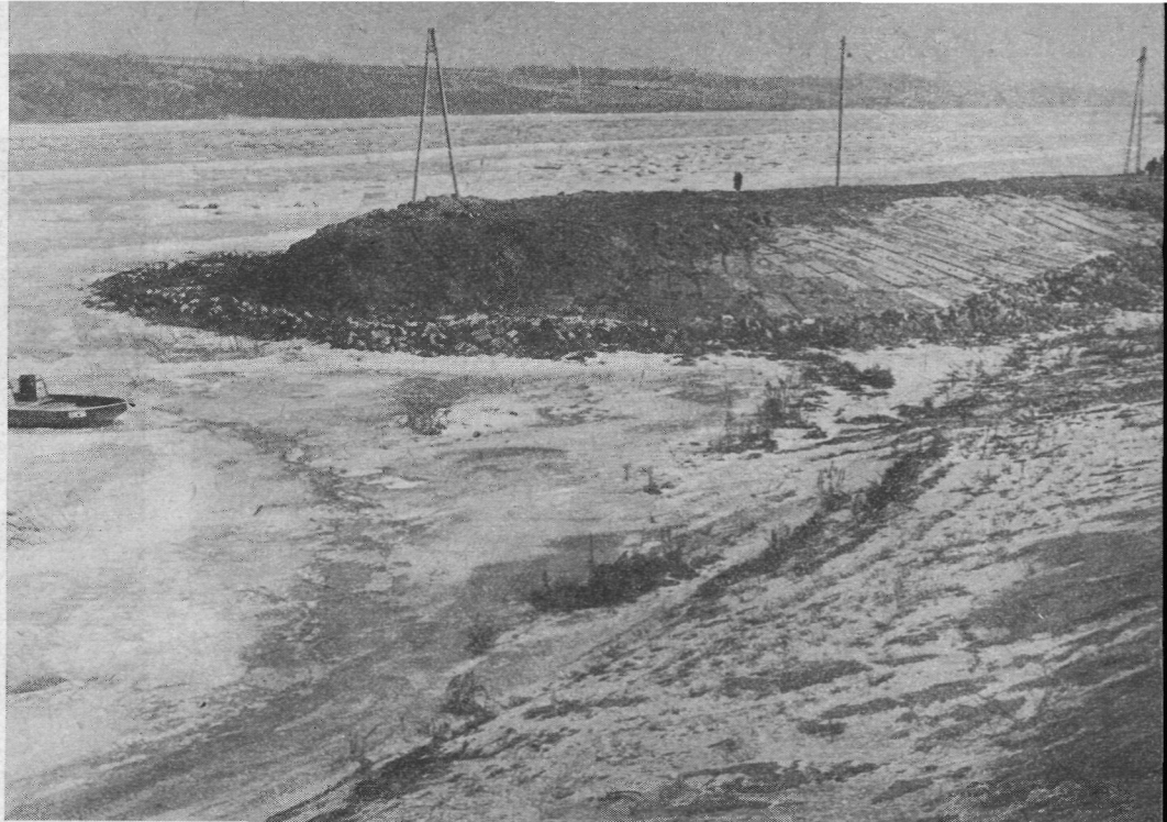
Miliony metrów sześciennych ziemi trzeba było przerzucić, aby usypać kilkadziesiąt kilometrów wysokich wałów, które uchronią okolicę przed rozlaniem się wód zgromadzonych w sztucznym jeziorze, które powstanie pod Włocławkiem
