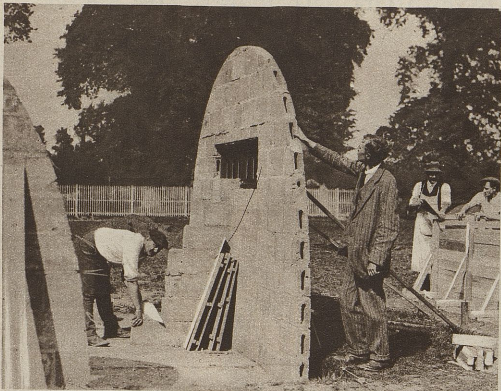
Détail de la construction de l'habitation en ciment que l'on édifie à Ruislip. Les diverses pièces, ayant les dimensions voulues, en sont moulées à l'avance ; il n'y a qu'à les monter suivant un plan.
