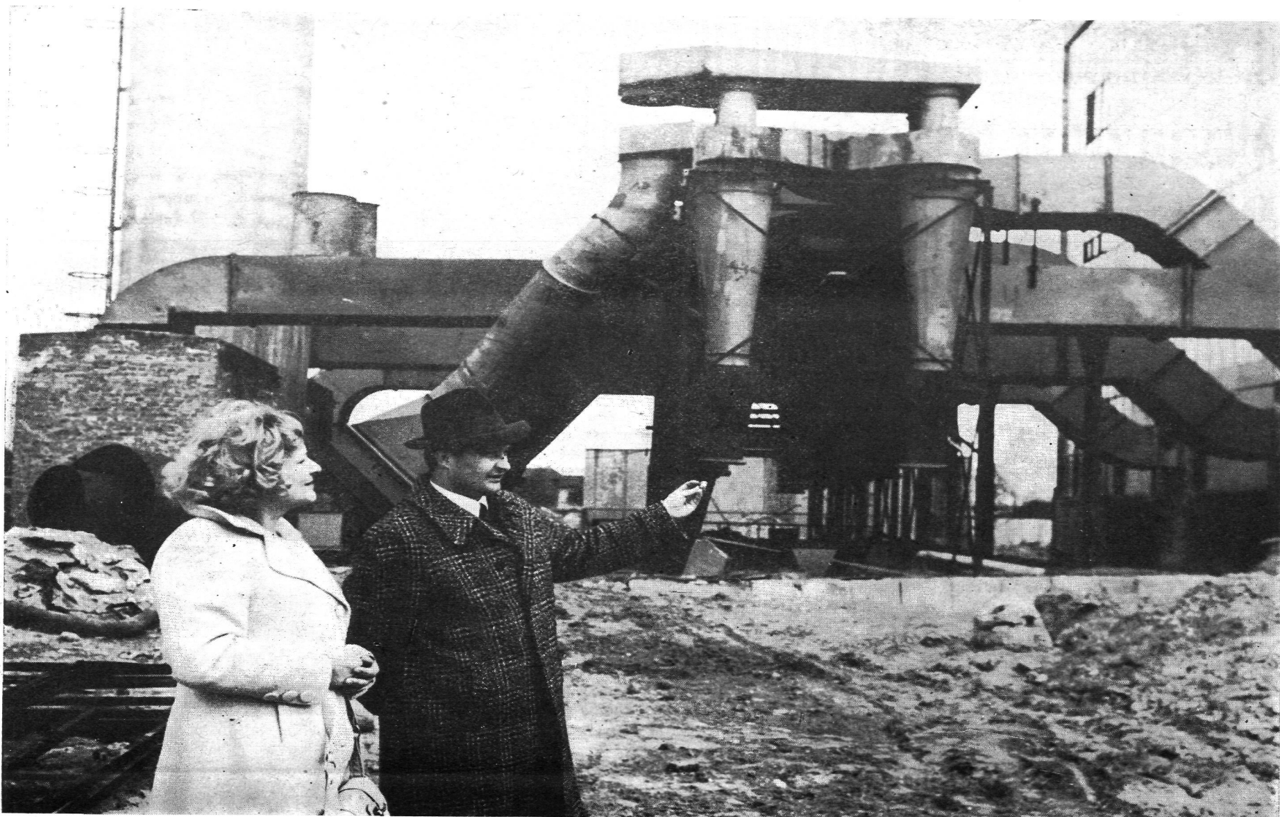
Elektrownia nie posypie pyłem, bo założono filtry i pochłaniacze, które na terenie budowy Zakładów Mięsnych ogląda p. mgr inż. W. Kosiuk, szef planowania
