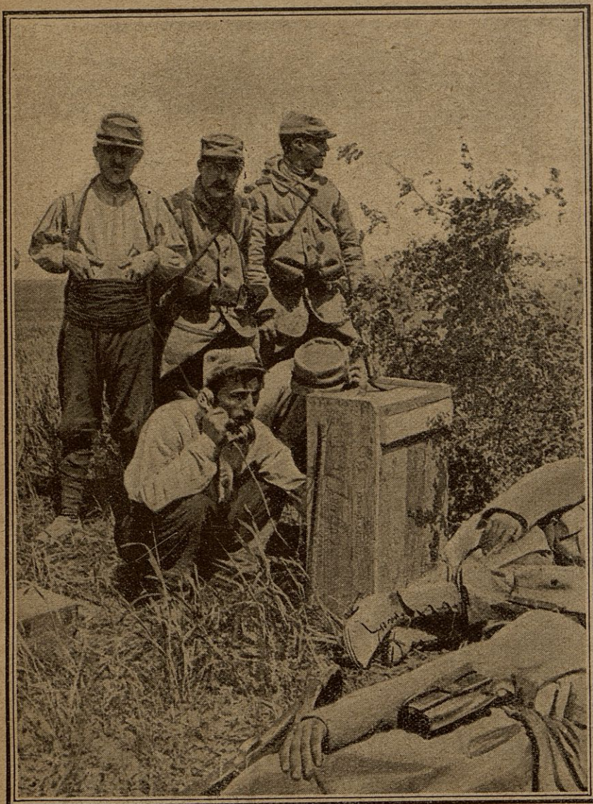
Une installation téléphonique est bientôt faite sur le front. Une fois la ligne posée, ce qui a lieu avec une rapidité étonnante, le poste est placé dans une caisse de bois ; le fil du poste est rattaché à la ligne et aussitôt les ordres se transmettent.
