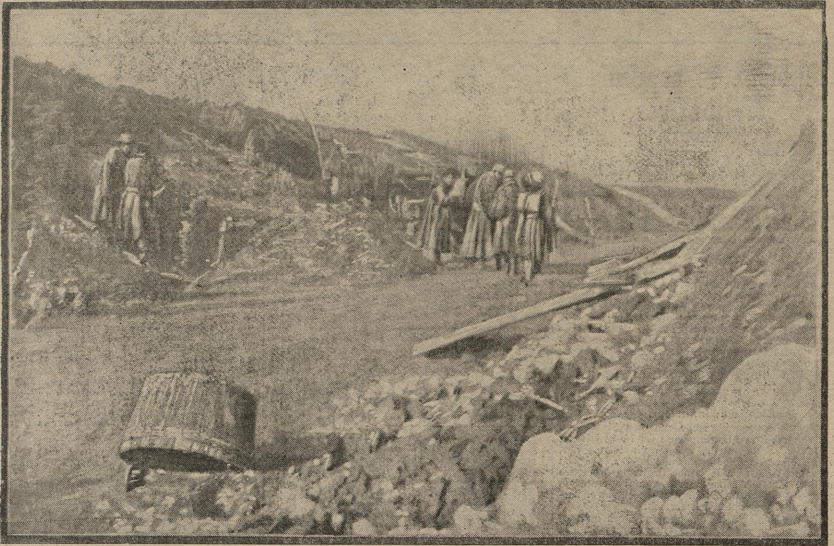
Afin d'être retranchés avec plus de sécurité, nos soldats construisent souvent leurs abris sur des routes. Celui que nous publions ici a été photographié en Argonne. Il est en voie de construction et s'étend sur plus d'un kilomètre.
