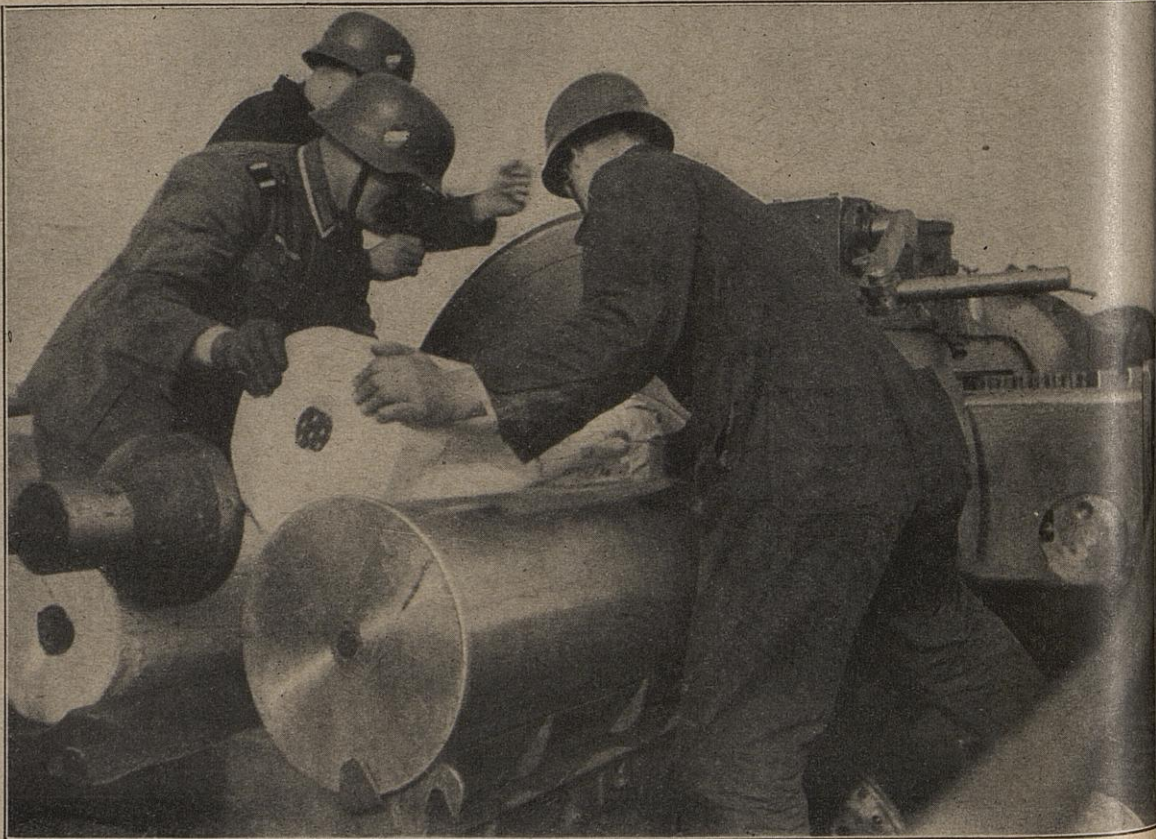
Auf kleinen Loren ist die Munition über die Plattform nach vorn gefahren worden; jetzt wird die manns hohe Granate und die mehrteilige Kartusche durch den Verschluß ins Rohr geschoben.
