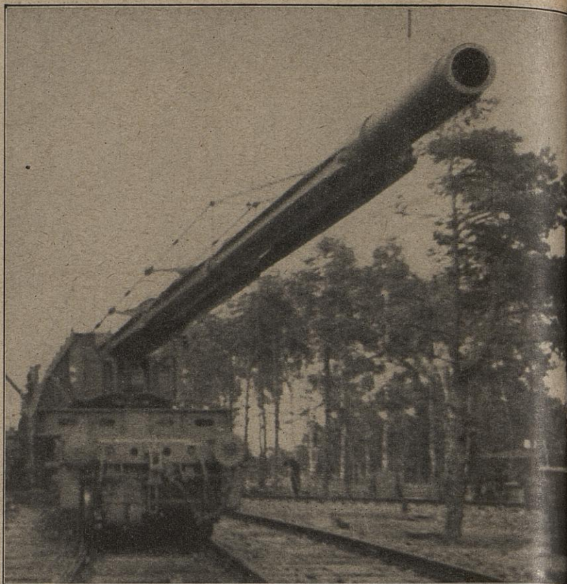
Langsam rollt ein Gigant auf Schienen nach vorn. Nur noch wenige Meter, dann hat er die Feuerstellung erreicht.
