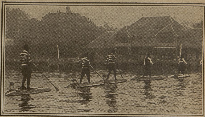
On a expérimenté au bois de Boulogne un « hydro-sky », appareil destiné à la marche sur l'eau. Il se compose de deux flotteurs en toile imperméable reliés à l'arrière par un axe sur lequel est montée une roue à quatre aubes, qui fait glisser l'appareil en avant.
