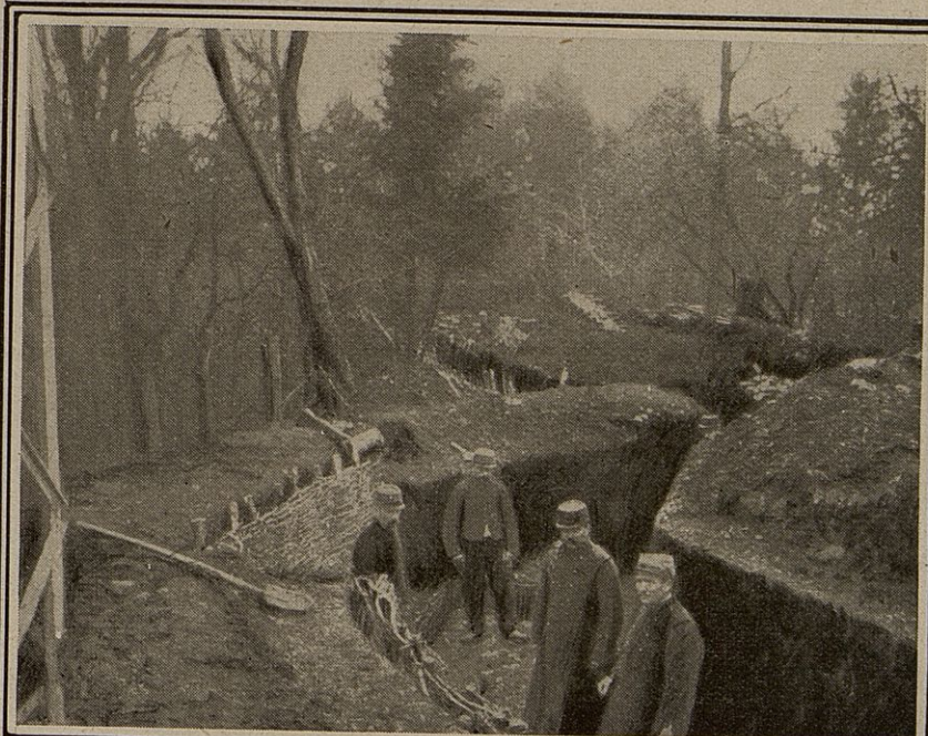
La tranchée est terminée ; on recouvrira le tout d'un toit fait de branches et de terre, et les shrapnells pourront pleuvoir.
