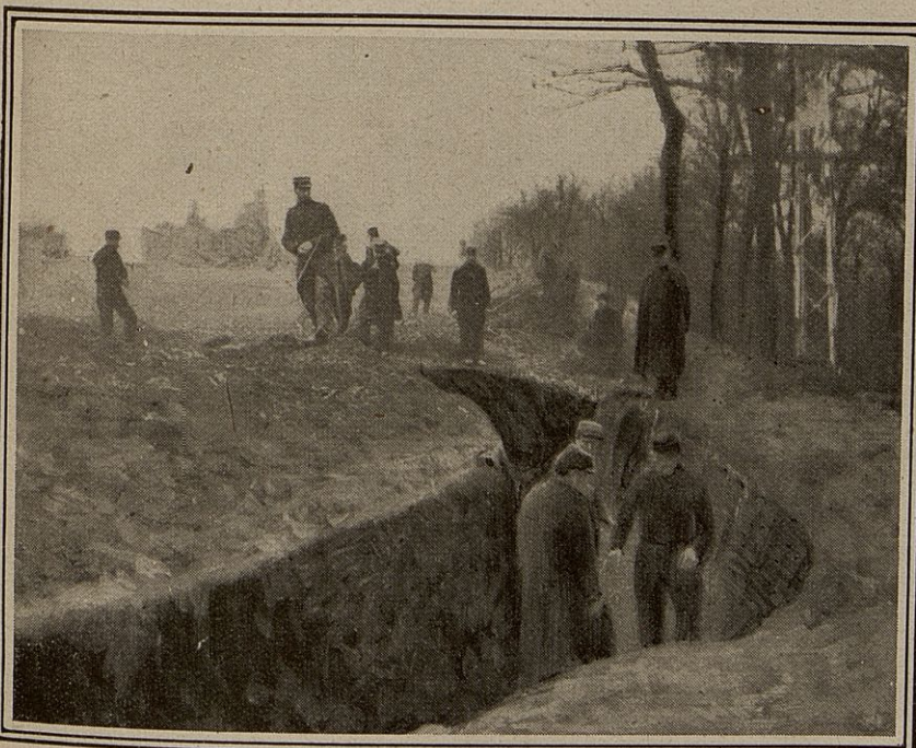
Afin que les terres ne s'écroulent point, on garnit les parois de claies ; dommage qu'on ne puisse faire aussi des parquets.
