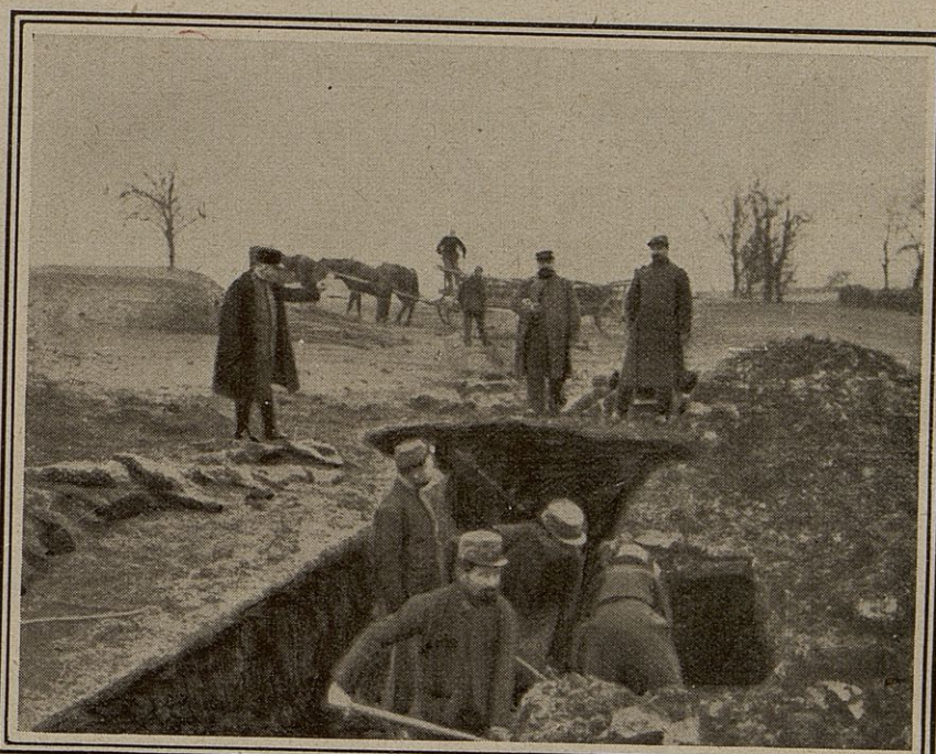
La tranchée va être finie : les hommes y disparaissent presque entiers ; encore quelques pelletées à enlever et ils seront à l'abri.
