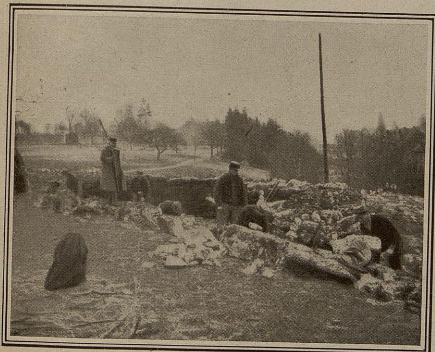
Le trou s'agrandit : la terre et les pierres extraites sont entassées au bord de la tranchée ; ainsi seront constitués d'excellents abris.
