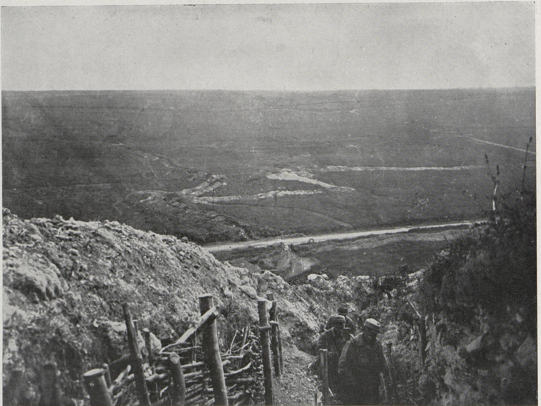
Ce qu'on peut voir, d'une de nos tranchées.
