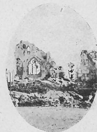
Ruines de l'église de Prosnès.
