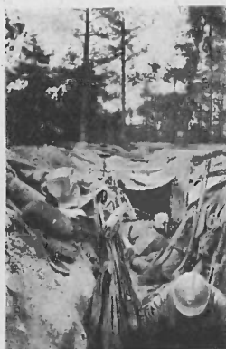
Une tranchée de l'Épine de Védégrange. (28 septembre 1915.)
