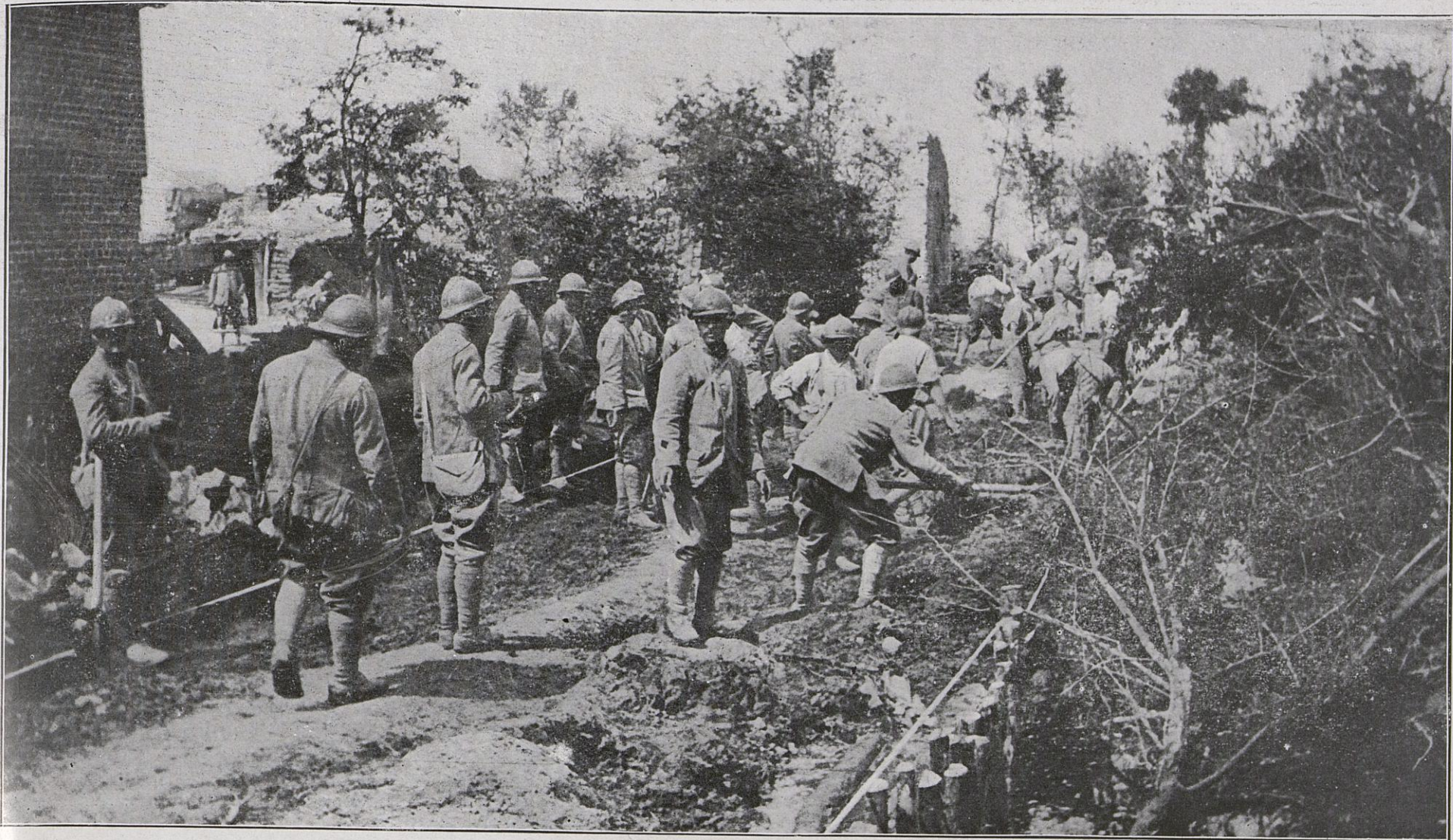
Pour amener nos pièces d'artillerie aux points désignés par le haut commandement, le génie travaille activement à établir des routes dont le tracé est marqué par des rubans blancs tendus de chaque côté de la voie désirée.
