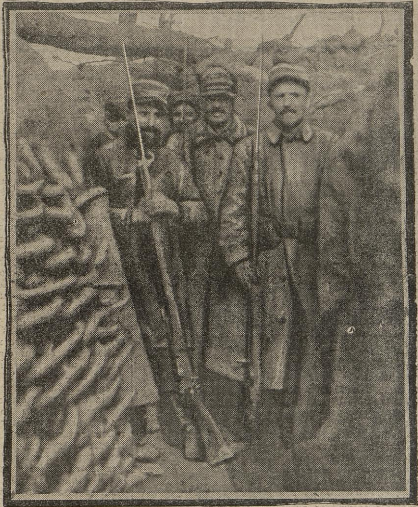
Il advient que les tranchées sont creusées dans des sols inconsistants : il faut les « parer » avec des branches entrelacées. Ce travail a été réalisé par les nôtres près des tranchées anglaises, où ce procédé est souvent usité.
