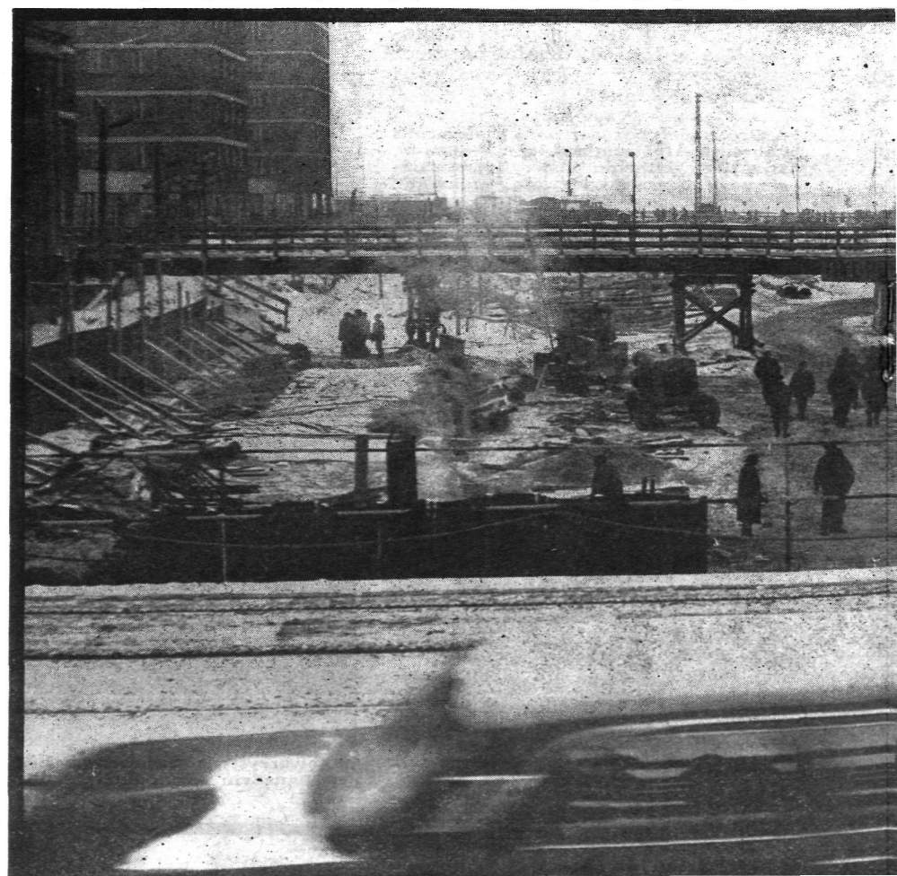
Teren budowy dwupoziomowego skrzyżowania ulic Polnej i Waryńskiego
