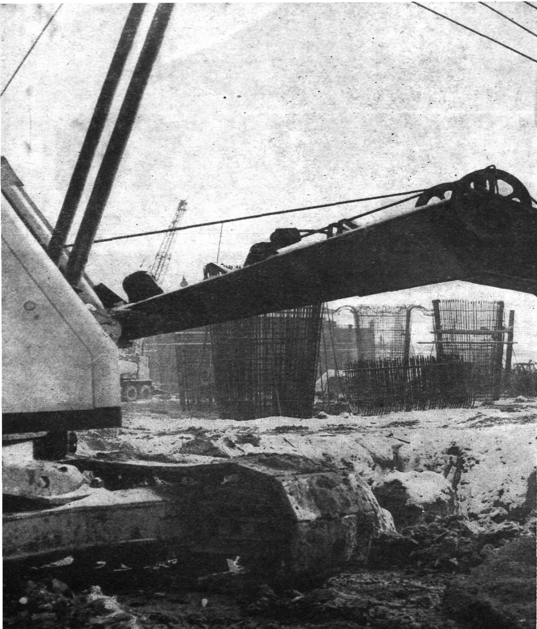
Tak oto wygląda plac budowy nad Wisłą w rejonie Saskiej Kępy
