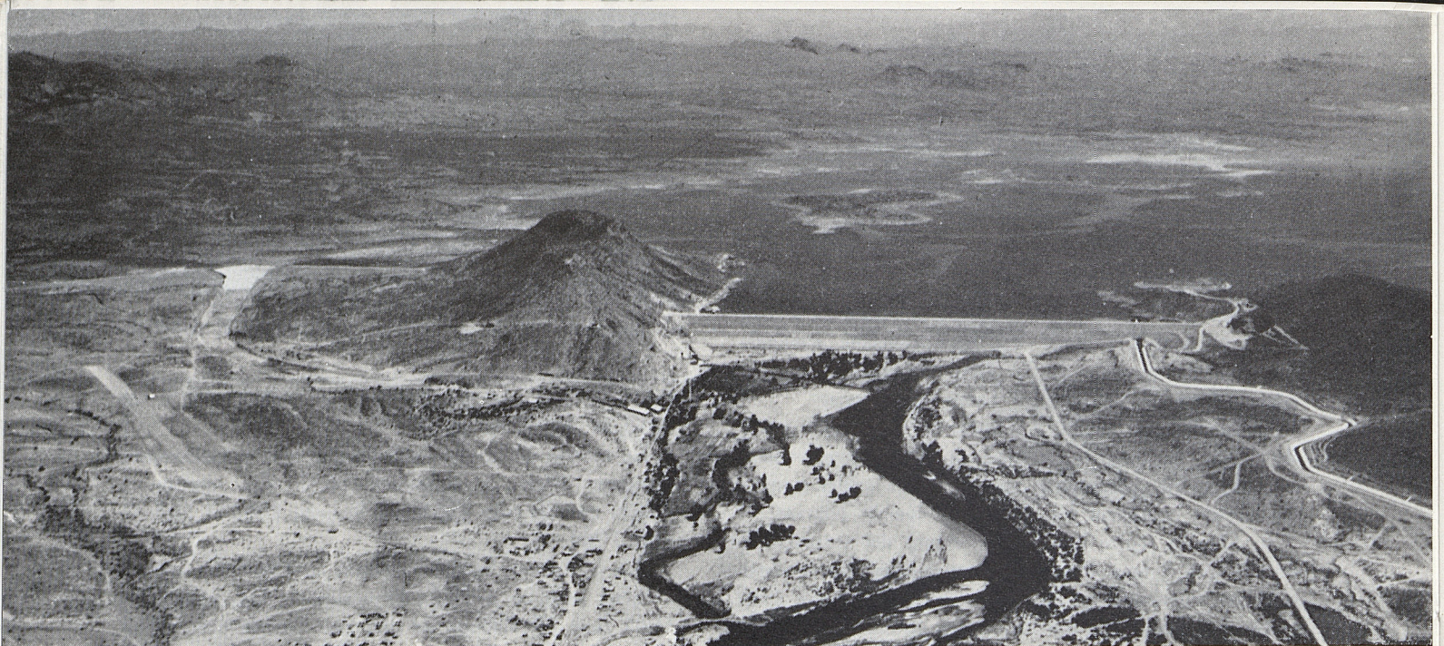
Barrage sur le fleuve Yaqui, au Sonora
