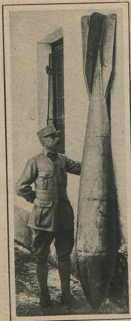
Grosse bombe-torpille lancée par avion. Son poids est de 300 kilogs. Sa hauteur de 2 m. 76 environ.
