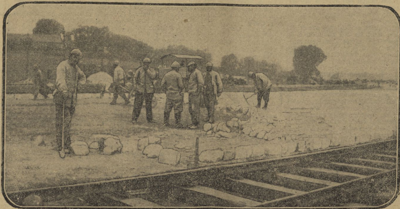
CONSTRUCTION D'UNE ROUTE PAR LES SOLDATS CANTONNIERS
