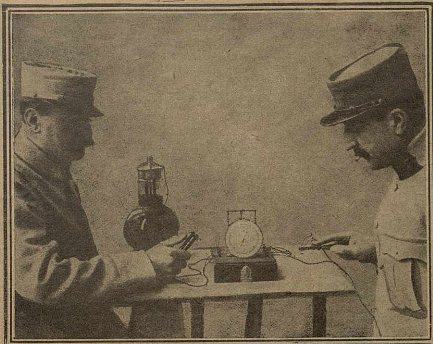
Le candidat aviateur, à gauche, va subir la première épreuve pour la réaction aux impressions visuelles ; il s'apprête à appuyer sur la presselle lorsque l'aiguille du chronomètre électrique de d'Arsonval sera mise en mouvement.
