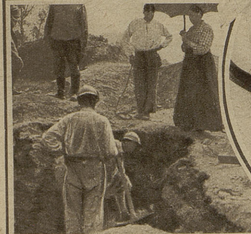
A Ch..., dans l'Oise, des soldats recherchent un trésor enfoui sous les décombres d'une maison bombardée.
