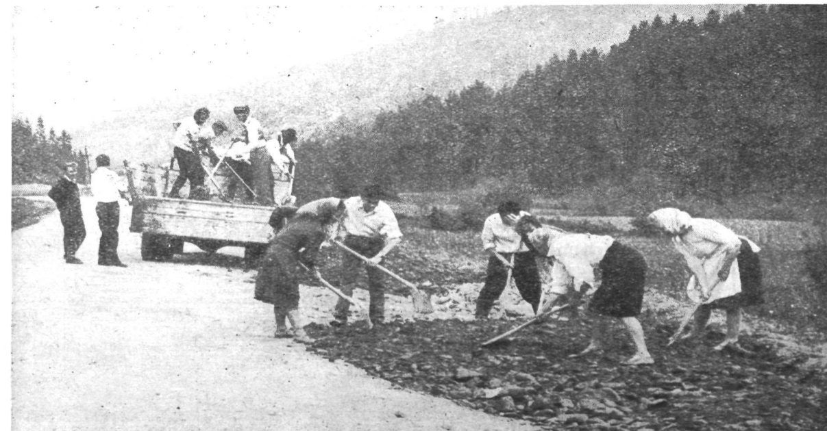
Każdego dnia przy budowie drogi pracowało przeciętnie 30 osób: mężczyzn i kobiet. Powoli, ale stawnie wykonano pod nadzorem budowniczych dróg podkład, ubito rozkruszony przedtem kamień
