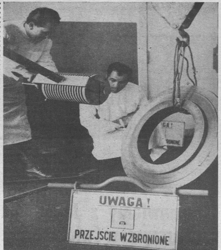
Badanie kobaltem tarozy turbiny okrętowej.
