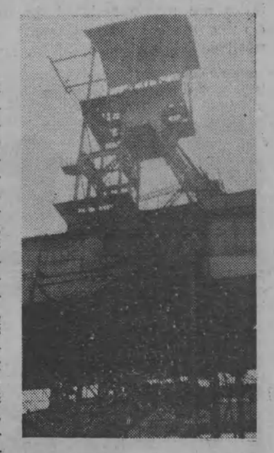
Szyb kopalniany La Mouriere w którym pracuje wielu Polaków.
