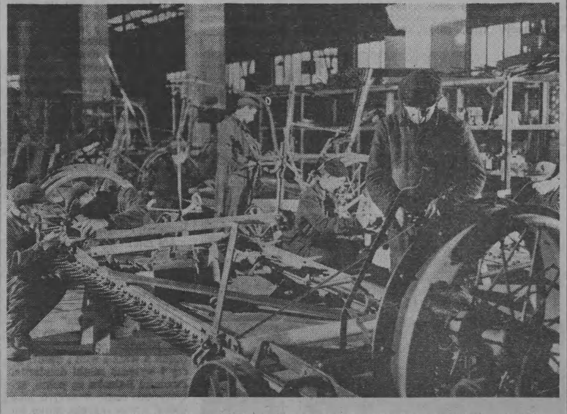
Na zdjęciu: Brygada montażowa Wacława Mikolajczaka montuje snopowiązałki ciągnikowe WC-1.
