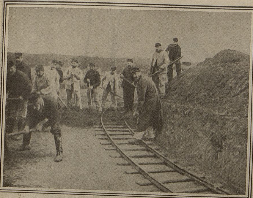
Les réservistes de l'armée territoriale du camp retranché de Paris construisent une voie stratégique pour le ravitaillement des batteries.
