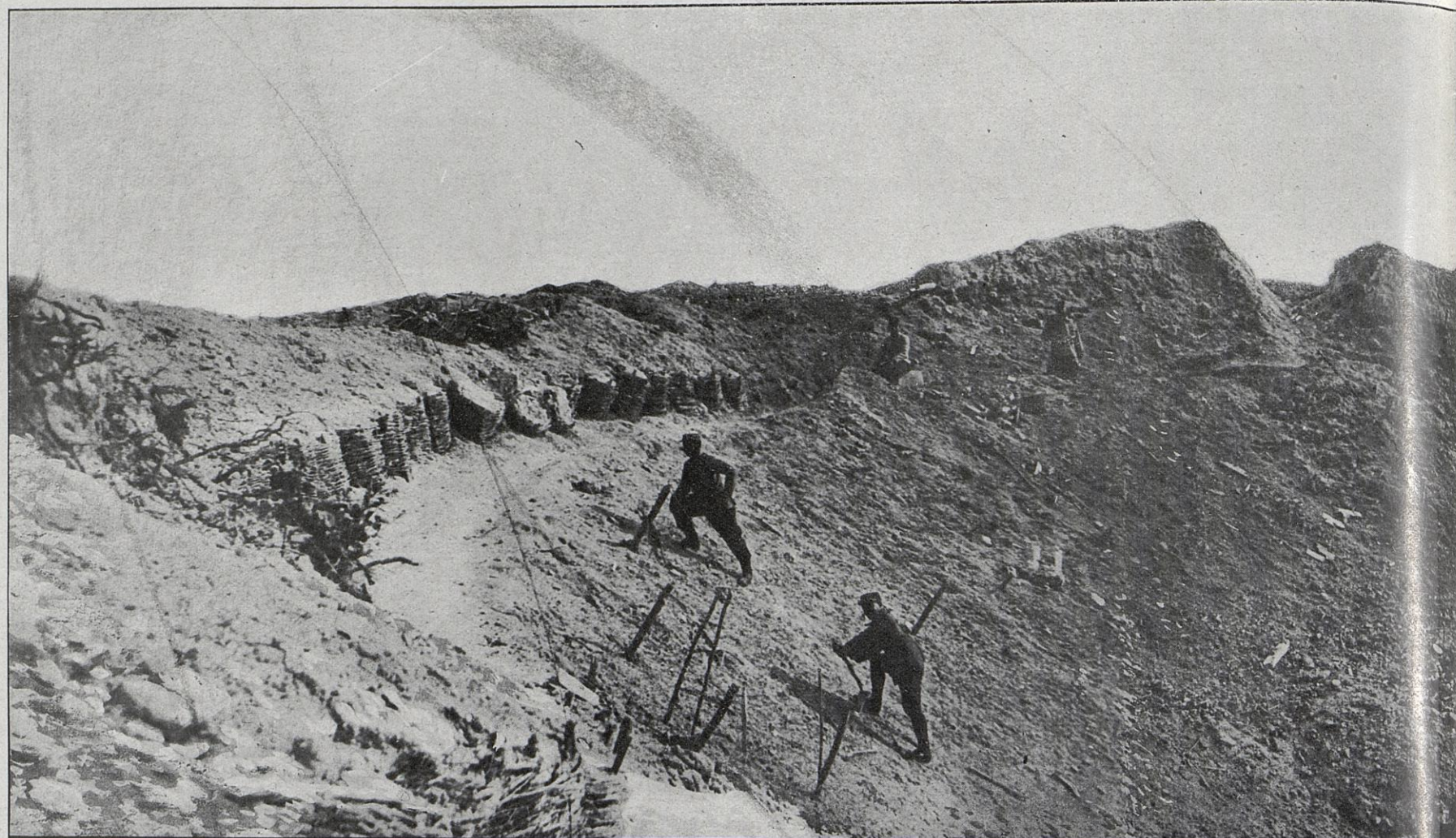
CRATÈRE EN AVANT SUR LE FRONT DE LA POMPELLE. — Cet entonnoir doit détenir le record de la profondeur et de la surface; il a été produit le 31 décembre dernier par une explosion de 20.000 kilos de mélinite qui ensevelit sous les décombres un nombre important des nôtres. Les tranchées allemandes et françaises n'étaient à cet endroit qu'à une distance de 50 à 80 mètres. Les Allemands parvinrent à occuper cette excavation. Le 2 janvier nous réussissions à les en déloger et depuis lors nous en sommes maîtres. La Pompelle lui-même. Il n'y parvint pas et les communiqués nous ont dit quelles pertes il dut subir dans cette action.
