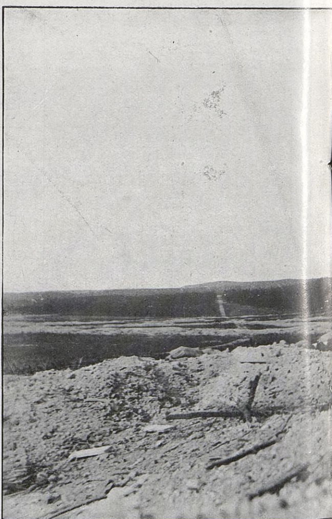
Les tranchées allemandes et le bois en V en avant du fort de La Pompelle. Cette photographie a été prise à l'extrême limite du front français dans cette région.
