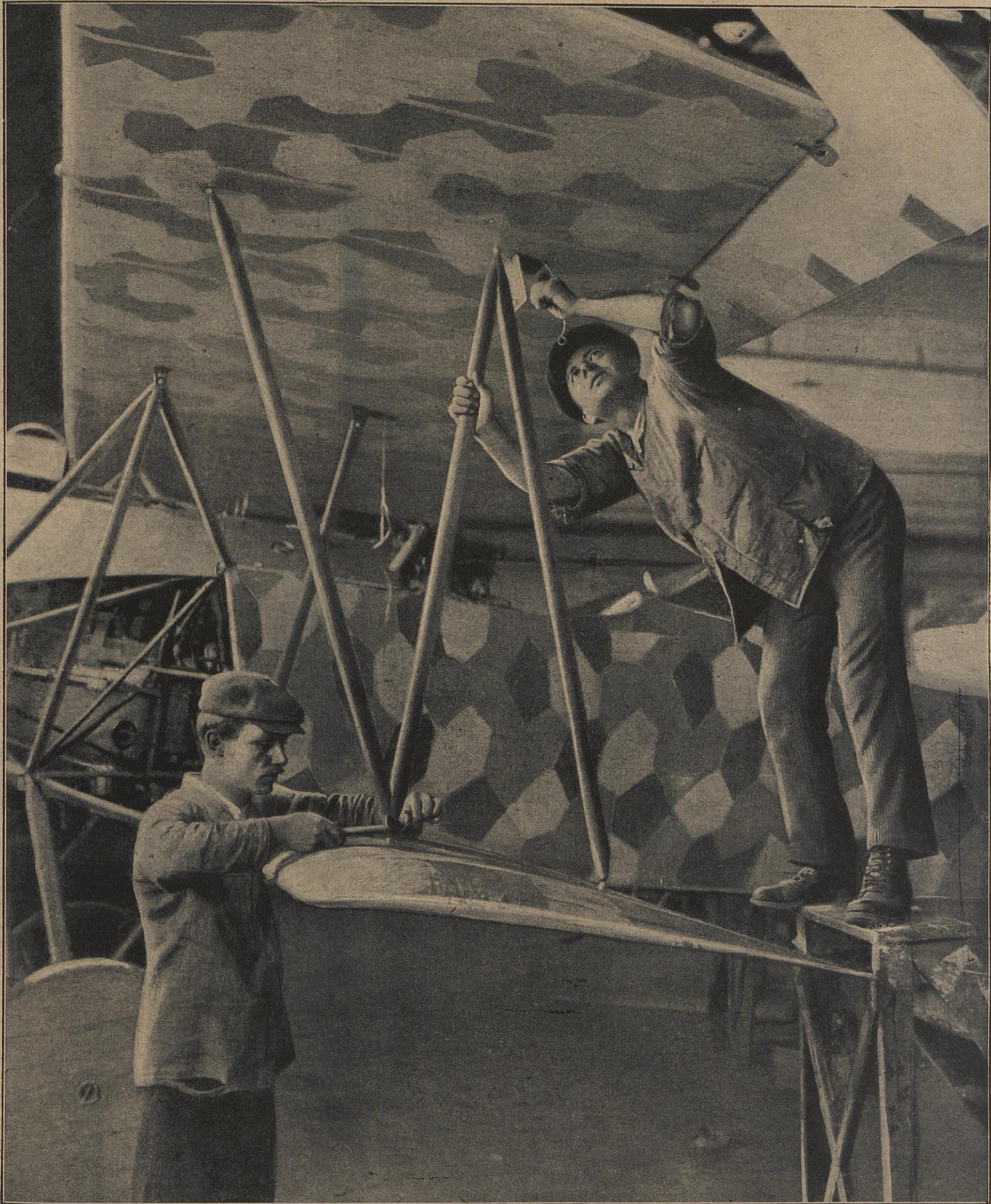
Vom Bau unserer neuen Flugzeuge: Versteifung der mit farbiger Schubbemalung versehenen Tragflächen.
