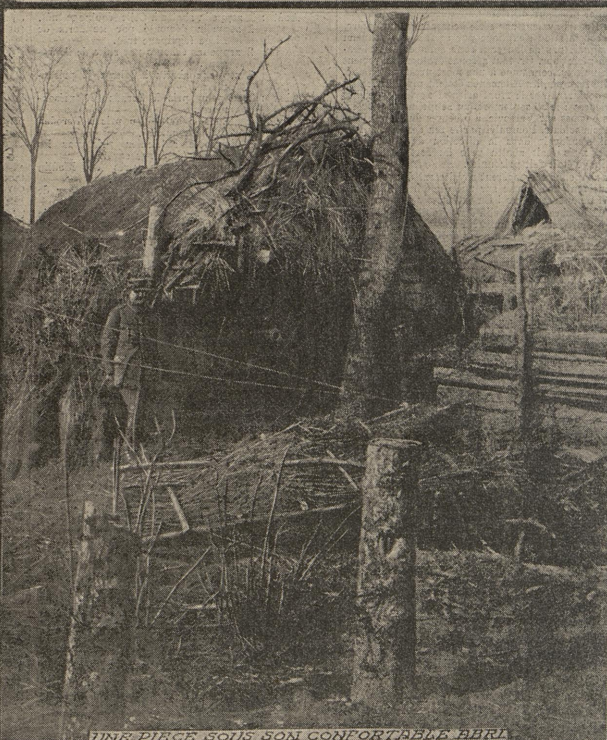
UNE PIÈCE SOUS SON CONFORTABLE ABRI
