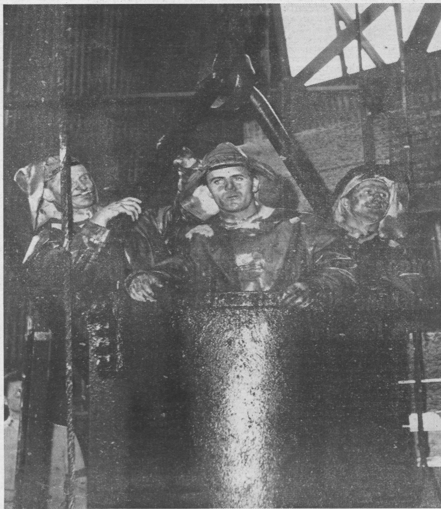
Pomiędzy powierzchnią, a przodkiem robót kursują kubły, które w zależności od potrzeby stają się „pasażerskie” lub „towarowe”.
