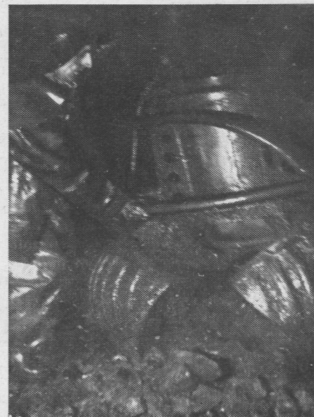
Górnicy na głębokości 260 metrów. Z góry ślepi woda, wszystko jest mokre i oślizgłe. Ładowarki swymi potężnymi szczękami chwytają i przenoszą urobek do kubłów.
