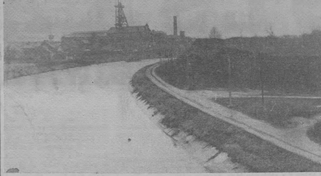
Widok na szymb kopalniany w Vieux-Condé (Nord). I tutaj, jak w innych kopalniach, pracuje wielu Polaków. Obok przechodzi kanał Skalda...
