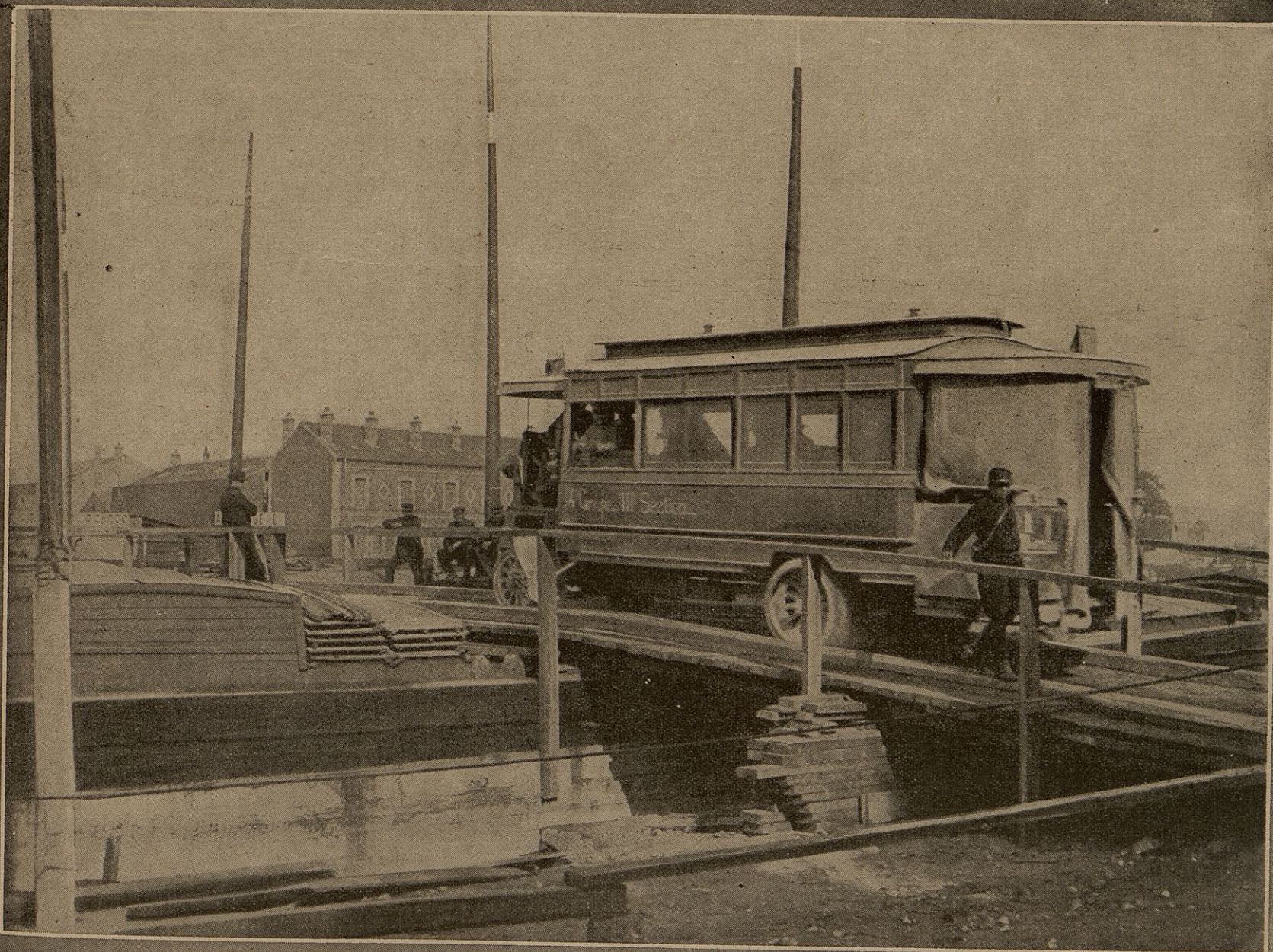
Le pont de Compiègne, détruit par les Allemands, a été rétabli provisoirement par le génie militaire français. On éprouve la solidité du tablier de fortune en y faisant séjourner un autobus parisien lourdement chargé.
