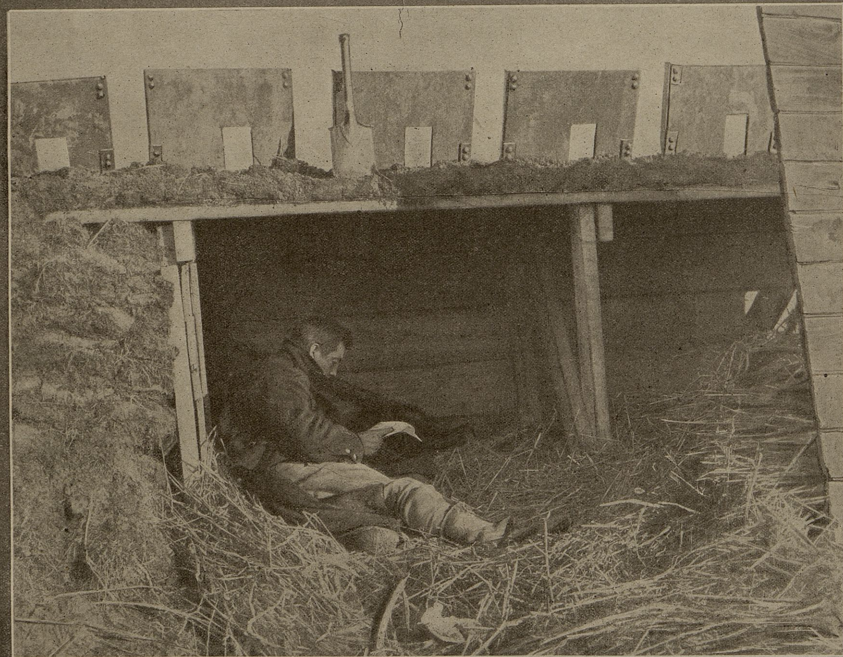
Certaines tranchées, établies au revers des talus du chemin de fer, le long de l'Yser, sont surmontées de plaques de blindage mettant à l'abri les tireurs. Et, dans la casemate ainsi protégée, le brave soldat belge lit paisiblement les lettres des siens.
