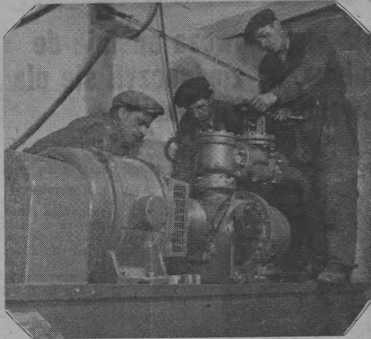
Elektrownia w Dychowie
