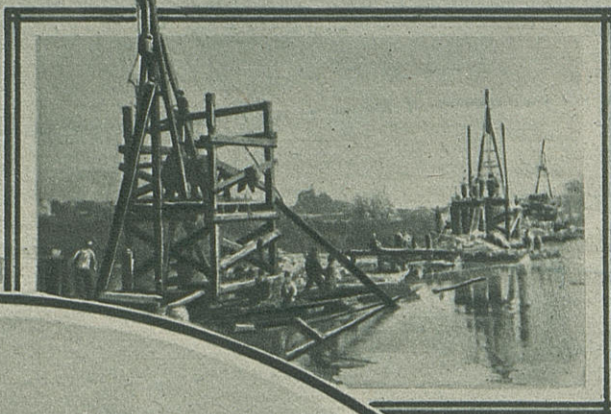
Les "sonnettes à vapeur" battent les pilotis.
