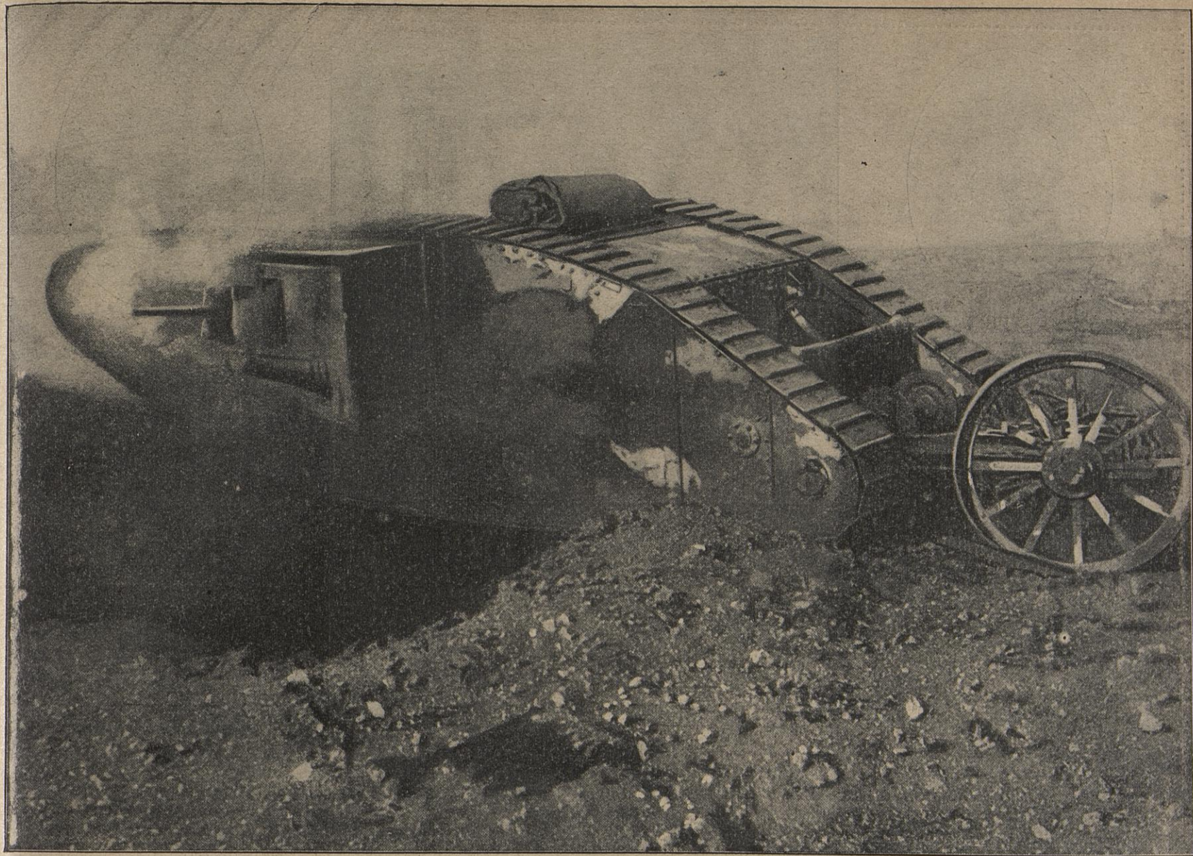
Die sonderbaren gepanzerten „Landkreuzer“, genannt „Tanks“, die die Engländer an der Westfront verwenden. Diese neuartigen Panzerautomobile können auf wegelosem Boden vorwärtstreiben, sind aber nicht weit gekommen, sondern bald von unserer Artillerie gefaßt worden. (Aus einer englischen Zeitschrift.)
