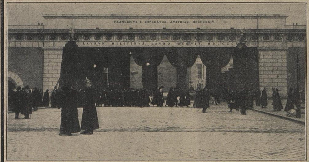
Das äußere Burgtor.
