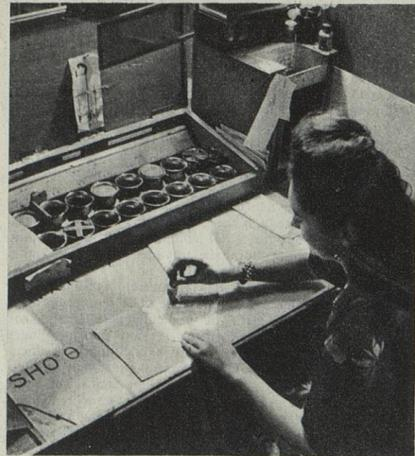
Le standard d'où les fiches de demandes de communication sont acheminées par tubes pneumatiques jusque dans les magasins les plus éloignés.
