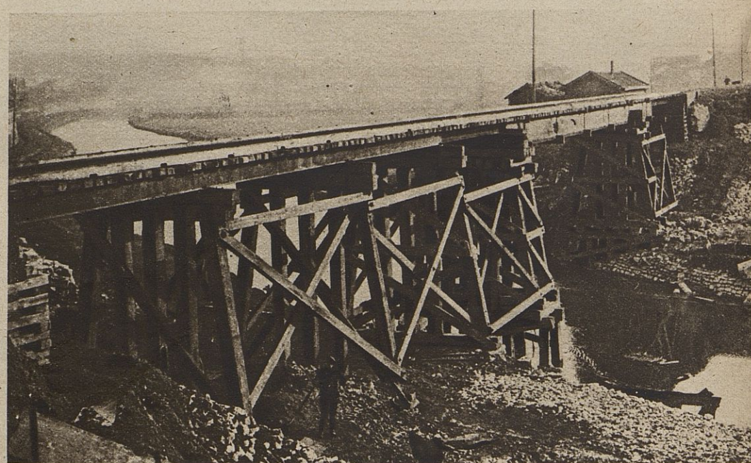
PRÈS DE LOUVROIL, LES TRAINS CIRCULENT SUR CE PONT DE FORTUNE.
