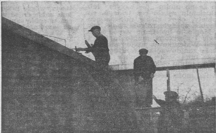
Przy budowie domu.
