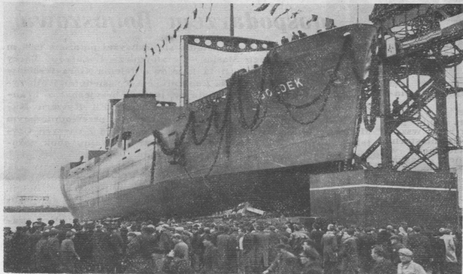
Już w roku 1948 nastąpiło w Gdańsku wodowanie pierwszego pełnomorskiego statku zbudowanego całkowicie przez polskich konstruktorów i robotników
