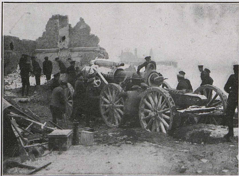
Pour dégeler les roues d'un obusier, on les a entourées de chiffons imbibés de pétrole, auxquels on a mis le feu.
