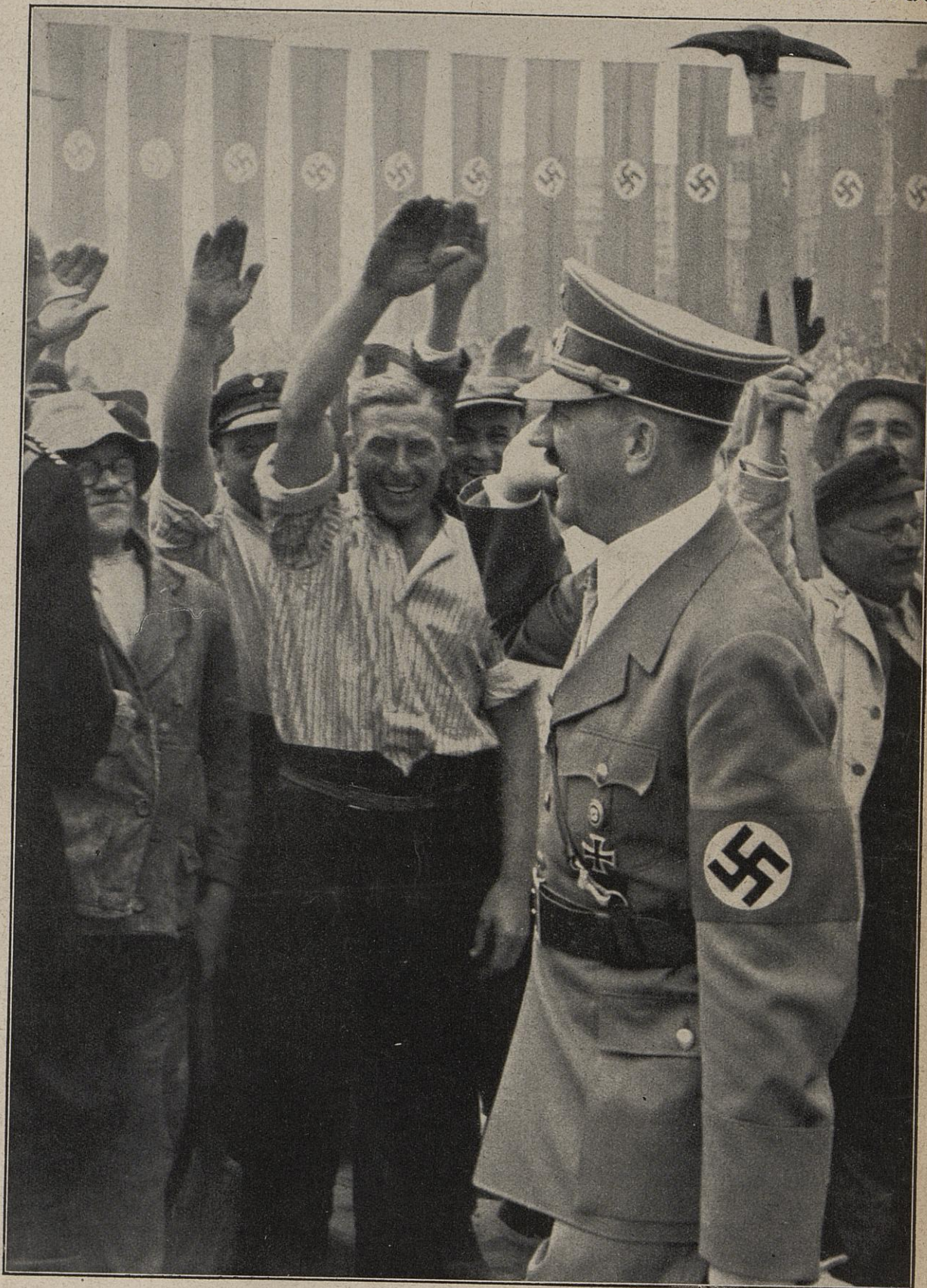
Von den Bauarbeitern amjubelt.
