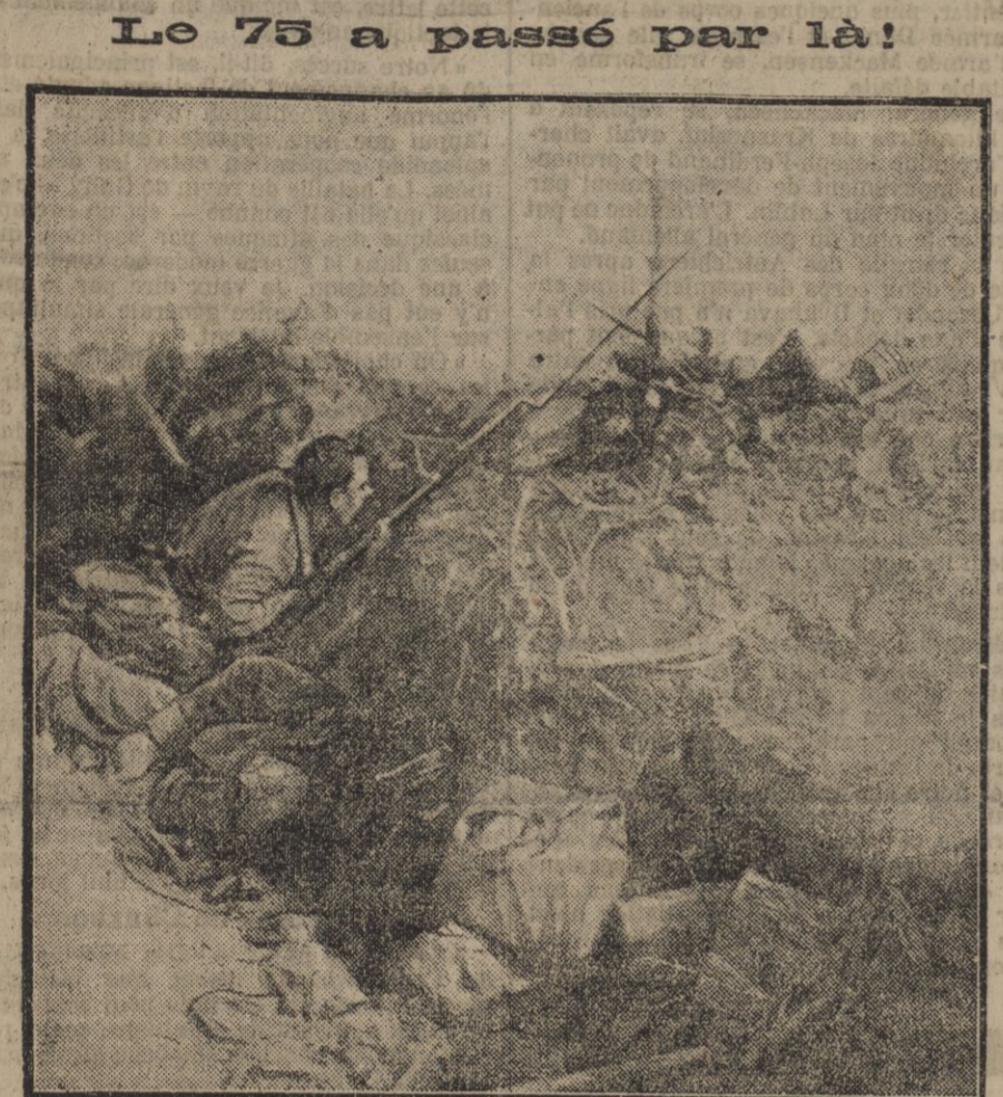
Cette photographie, dont nous garantissons l'authenticité, a été prise aux environs d'Ypres. Elle montre un tranchée allemande après le bombardement de Trossas. Les soldats sont morts, même celui qui semble tenir encore son fusil.
