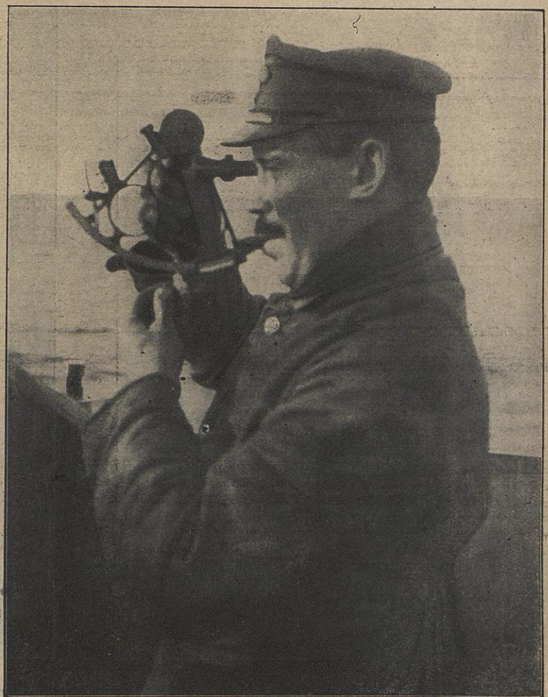
Messen der Sonnenhöhe zur Ortsbestimmung. (Der Steuermann)
